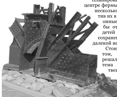
Фрагмент Николаевского моста, сохранившийся в Костроме
